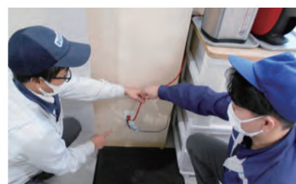
オール小島のサプライヤー各社で防火点検を実施
